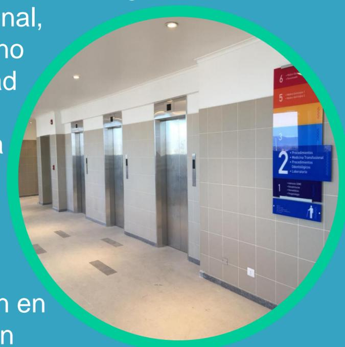
Entre algunas de sus características destacan botones con señalización en Braille, cabinas de construcción metálica con revestimientos de acero inoxidable, dispositivo interior de socorro, limitador de carga con alarma, sensores sísmicos calibrados, etc.
